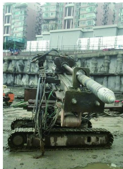
图3 PDH-130型旋冲挤密矛头试验现场
