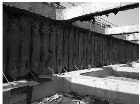
图5 钻孔咬合桩的施工效果
