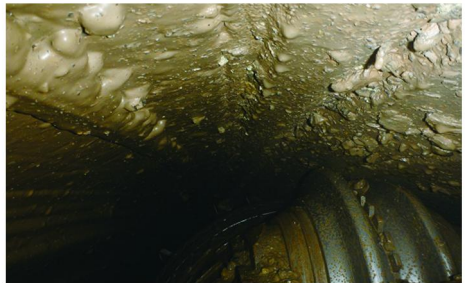
图 2 开仓查刀泥膜图片
