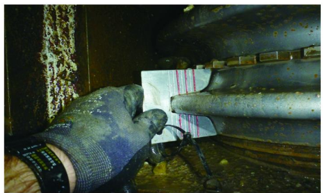
图 3 滚刀磨损检查
