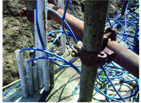
图 5 注浆过程中闸基上穿线管内冒水
