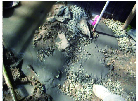
图 6 注浆过程中闸基外降水井口冒浆
