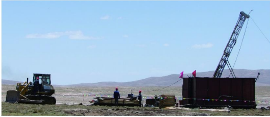
图1 全液压钻机安装的爬犁和钻机房
