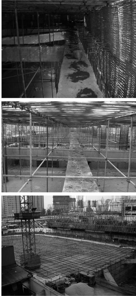
图7 露天爆破防护棚搭设实例照片
