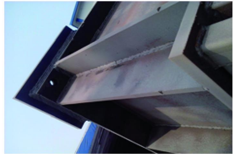
图3 喷砂作业完成效果
