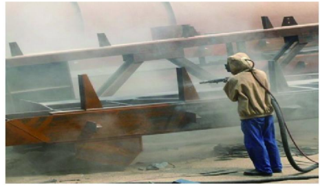
图2 喷砂作业现场
