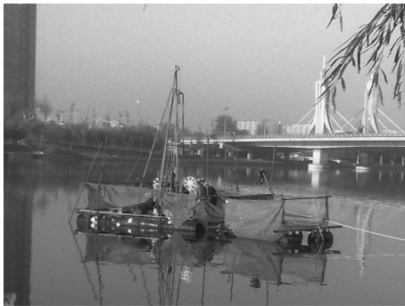
图2 施工现场油桶筏水域钻探平台实物照片
