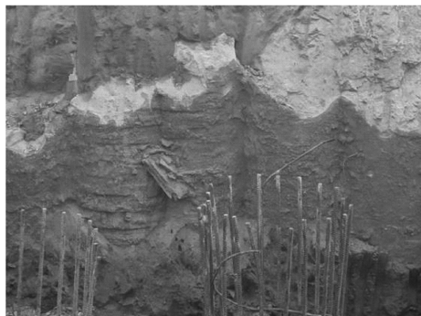
图2 上部弱加固区三轴搅拌桩剖面图
