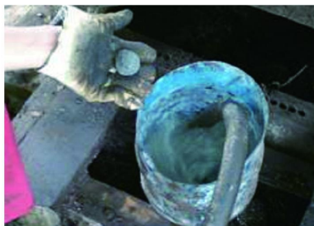
图6 用水泵将沥青球冲入孔中
