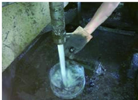
图5 用机上钻杆开泵将沥青球冲入孔中
