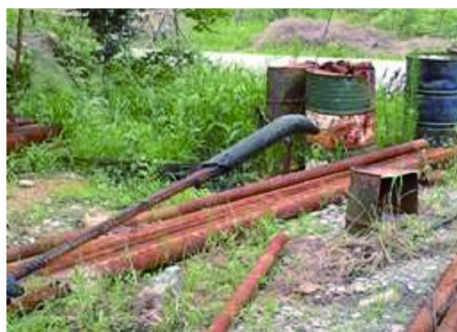
图8 用螺纹钢将沥青掏出
