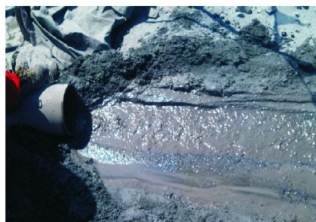
图5 孔内涌水后空气潜孔锤返渣照片
