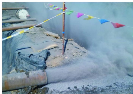
图4 空气潜孔锤正常返渣照片
