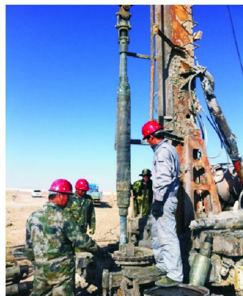
图4 下入井内压裂器具
