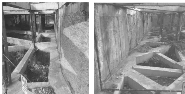
图6 地连墙墙壁开挖效果图
