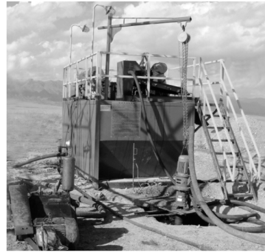
图 1 GK-15 型地质岩心钻探泥浆固控装置现场使用图
