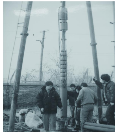
图5 潜水泵加封隔器
