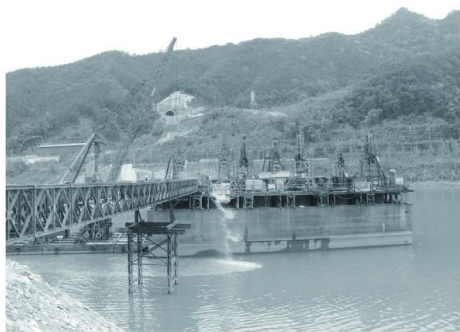
图4 钻机在合(肥)福(州)高铁联络线闽江特大桥10号墩施工
