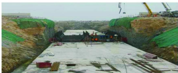
图5 高压旋喷支护与帷幕灌浆止水施工后的效果图
