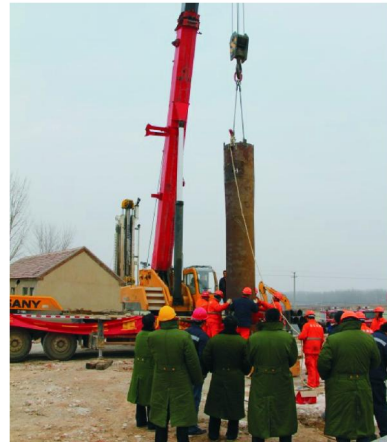
图6 利用吊车吊放、埋设护筒
