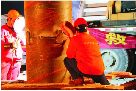
图7 施工人员正在焊接、安放护筒
