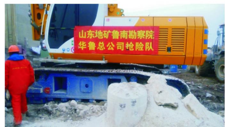
图8 旋挖钻机钻进过程中取出的岩心
