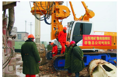
图 5 BG26 型旋挖钻机正在进行大直径救生孔钻进
