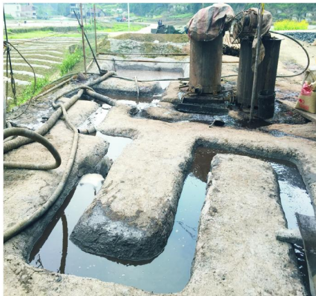
图6 钻井液循环系统图
