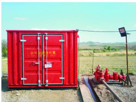
图4 远程控制台及压井管汇
