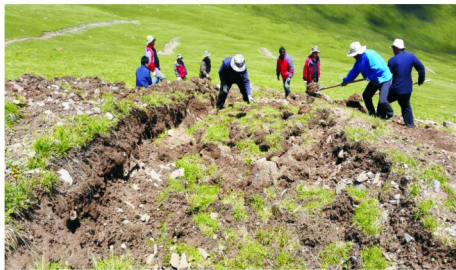
(a) 施工结束后在工区种植草籽
