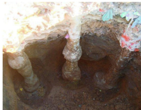
图 3 放电后所成葫芦状桩型
