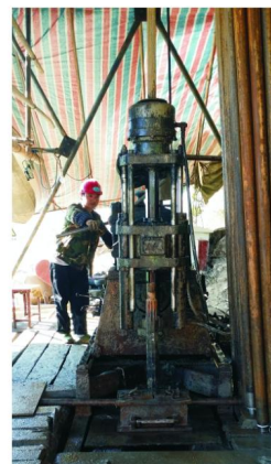
图6 下放波纹管管串
