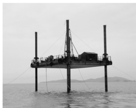
图8 多功能地质勘察平台施工现场图
