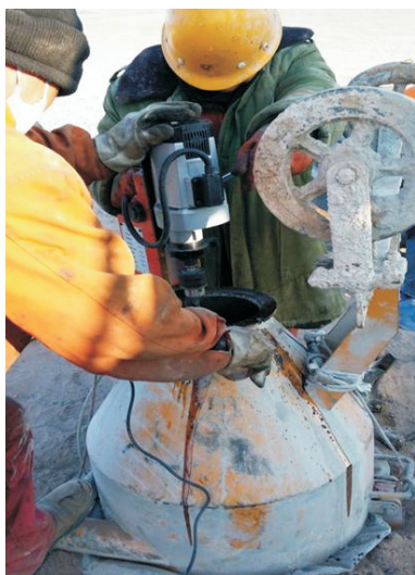
图8 正在为单出口取样器的出口法兰钻眼
