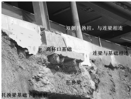
图 3 托撑加固现场
