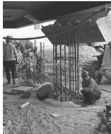
图 5 钢筋笼制作与下放现场
