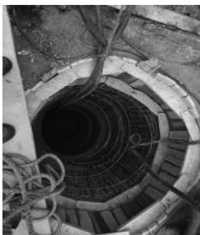
图4 人工挖孔施工
