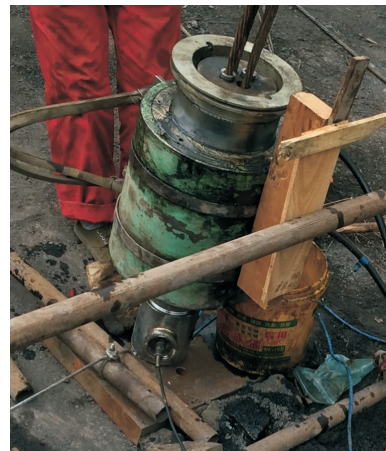
图4 自承载式预应力锚索初始张拉
