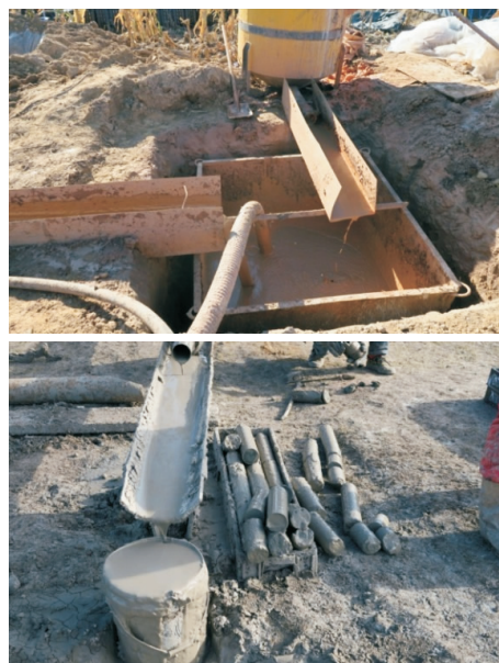
图 4 泥浆不落地措施
