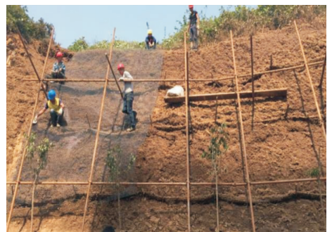
图5 铺设第二层土工格栅
