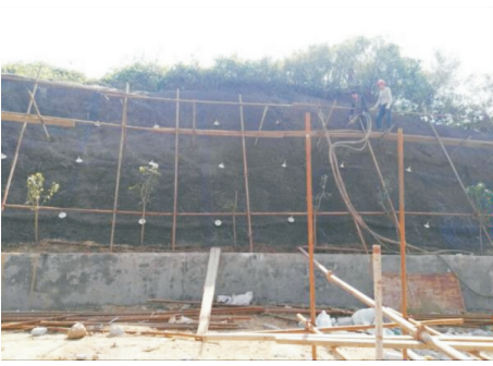
图 6 安装顶层锚头
