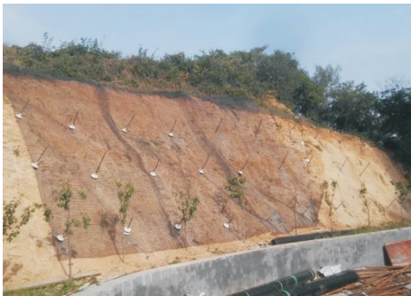
图4 铺设第一层土工格栅
