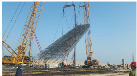
图8 钢筋笼吊装
