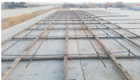
图7 圆弧形钢筋笼加工
