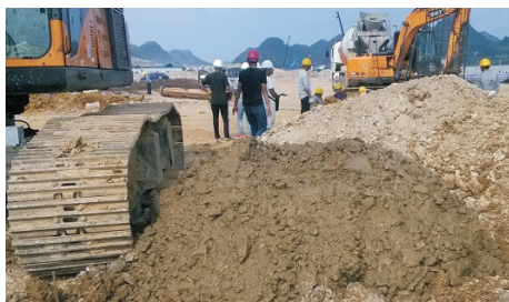
图 3 回填混合土后复打渣土情况
