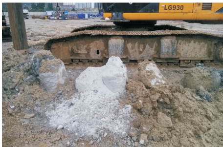
图5 回填素混凝土后钻出的混凝土柱和孔底岩柱
