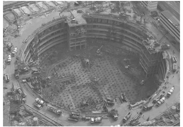
图 2 上海中心大厦支撑实景图
