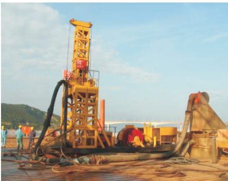
图6 采用气举反循环时钻机的工作状态
