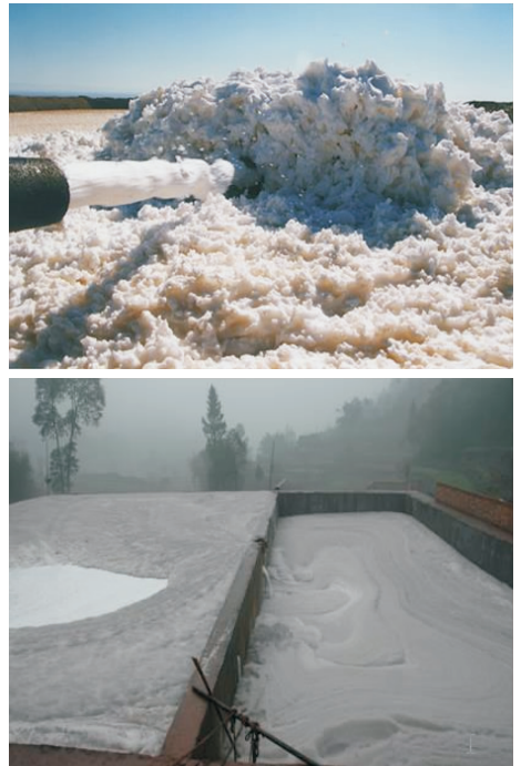
图 1 泥浆池堆满泡沫
