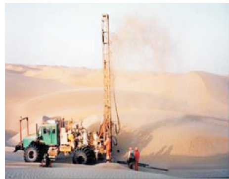
图 3 空气反循环连续取样钻进
