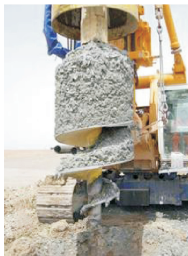
图 8 青藏铁路施工现场
