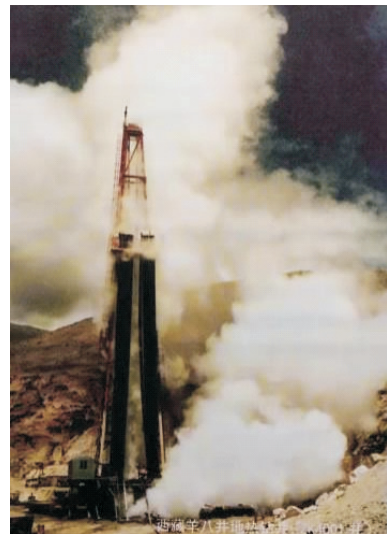
图 4 西藏羊八井高温地热钻井(ZK4001 井)现场
