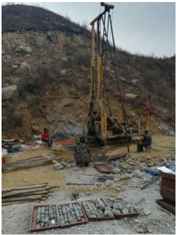
图 3 XY-2 型岩心钻机施工现场 Fig.3 Drilling site of XY-2 drill rig
