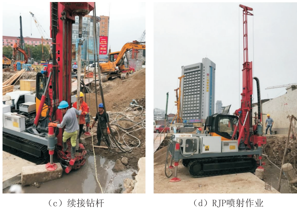
图4 钻机施工现场
