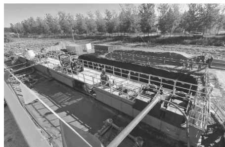
图 3 钻井液固控循环系统在雄安新区地热 D20 探采井工程应用现场
