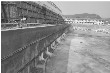
图6 基坑施工完成后现场照片
