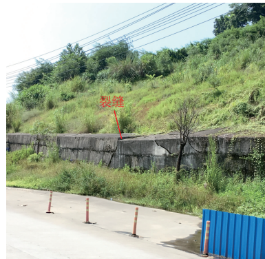
图 3 坡脚挡墙裂缝
