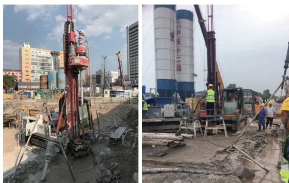
(a) 南京某施工工地
