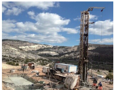
图 6 SDC1500 型车载钻机现场施工照片
