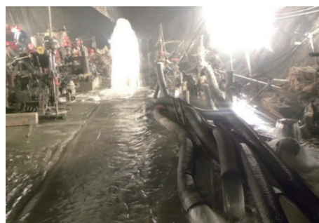
图 2 现场钻孔勘探
