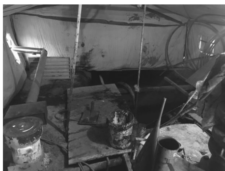
图 4 现场冬季防寒措施
