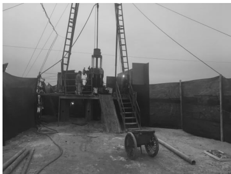
图 3 现场防风措施
