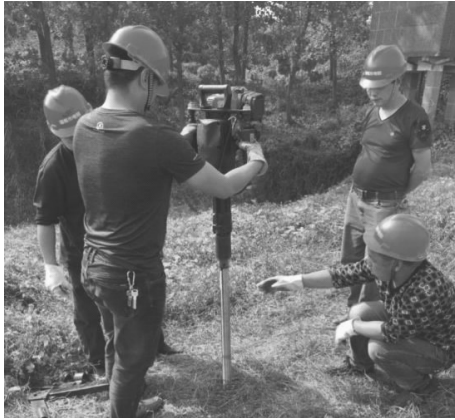
图 9 施工现场 Fig.9 Construction site
