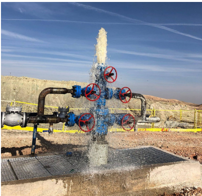
图 5 直井连通瞬间井口涌水
