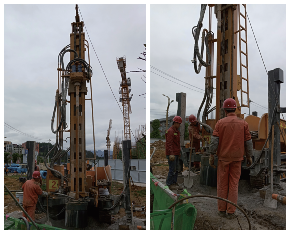
图8 浅层地温能钻探施工现场
