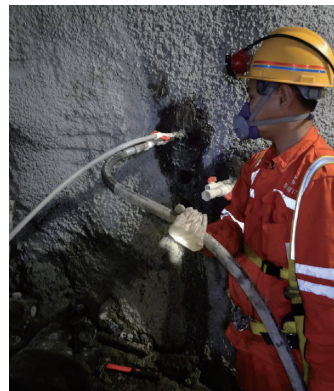
图4 近水平孔封孔灌注
