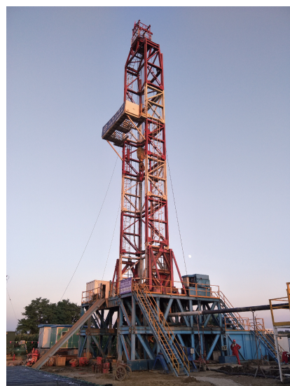
(b)施工现场
